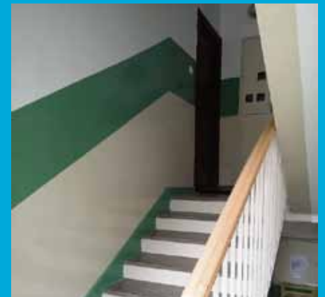
Wyremontowana klatka schodowa w budynku przy ul. Wyszyńskiego 17. Nowa kolorystyka oraz drewniane poręcze będą obowiązującym standardem przy kolejnych tego typu modernizacjach na naszym osiedlu
