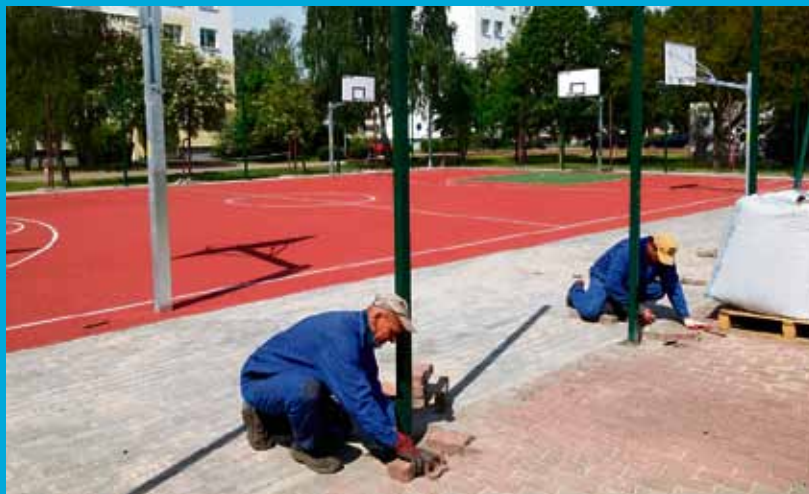
Boisko zlokalizowane na nieruchomości Anna niedługo zostanie oddane do użytku. Obecnie trwają ostatnie prace wykończeniowe. Będzie to boisko przeznaczone do gry w koszykówkę
