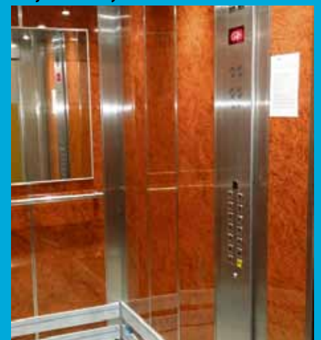
Nowy dźwig osobowy przy ul. Konst 3 Maja 13E. Większy szyb pozwolił na zamontowanie ponadstandardowej kabiny. Udźwig zwiększył się aż do 1000 kg. Wcześniej w tym miejscu funkcjonowała winda osobowa z zamykanym przedziałem towarowym
