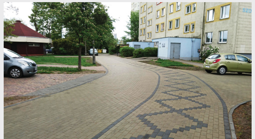
Nowa nawierzchnia pieszojezdni z kolorowej kostki betonowej przy Szosie Lubickiej 160-162
