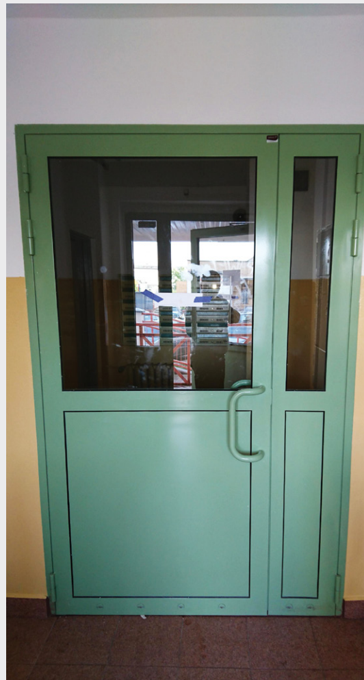
Wymienione drzwi z wiatrołapu do klatki schodowej na Konst. 3 Maja 13. Na osiedlu w tym roku wymieniono łącznie 38 sztuk takich drzwi
