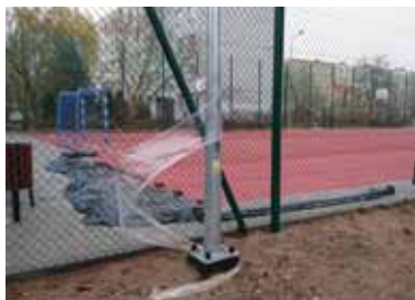
Końcowe prace na boisku przy ulicy Szosa Lubicka 154
