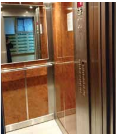
Nowa winda przy ulicy Szosa Lubicka 174A
