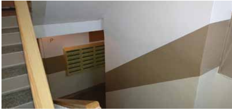
Drewniane poręcze oraz nowa kolorystyka to już standard przy modernizacji klatek schodowych - Szosa Lubicka 150
