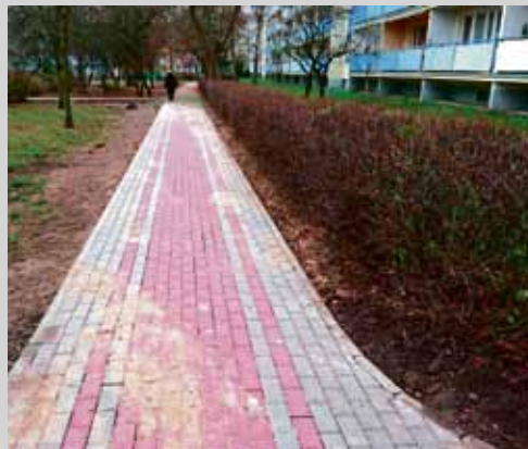
WYREMONTOWANA NAWIERZCHNIA CHODNIKA PRZY PREJSA 1
