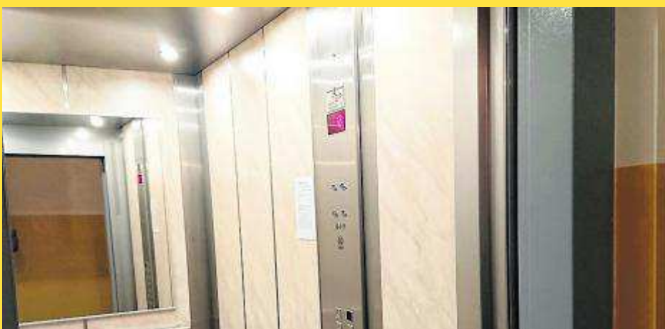
Dwie nowe windy oddano do użytku w budynkach przy ul. Ligi Polskiej 5A oraz Wyszyńskiego 15B. W tym roku wyremontowano 12 wind - w przyszłym będzie ich już 14
