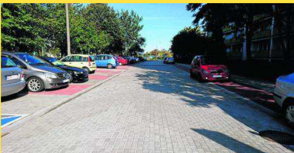
Wyremontowana nawierzchnia parkingu przy ul. Ligii Polskiej
