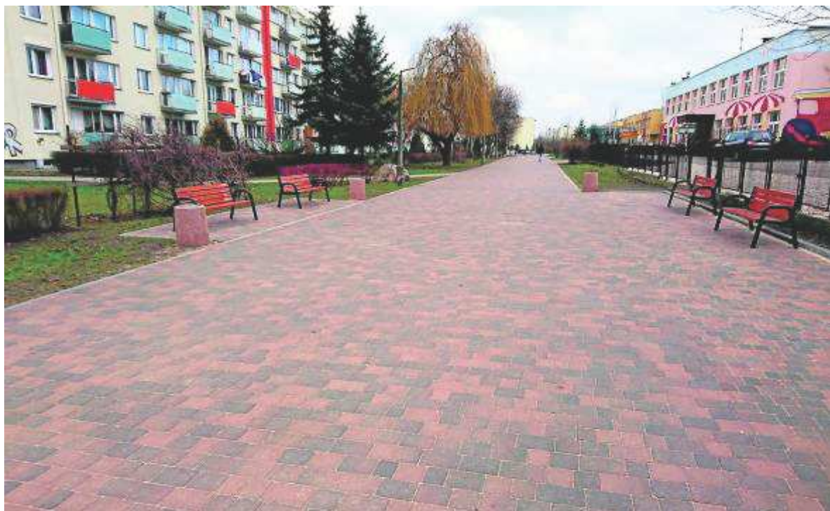
Aleja łącząca ul. Wyszyńskiego oraz Ligii Polskiej została zmodernizowana ze środków budżetu partycypacyjnego
