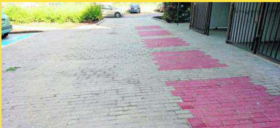
Zmodernizowane nawierzchnie przy ul. Szosa Lubicka 180. Do końca roku zostanie wymienionych 5862m2 nawierzchni na całym osiedlu
