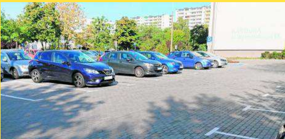
Przebudowany parking przy ul. Bolta
