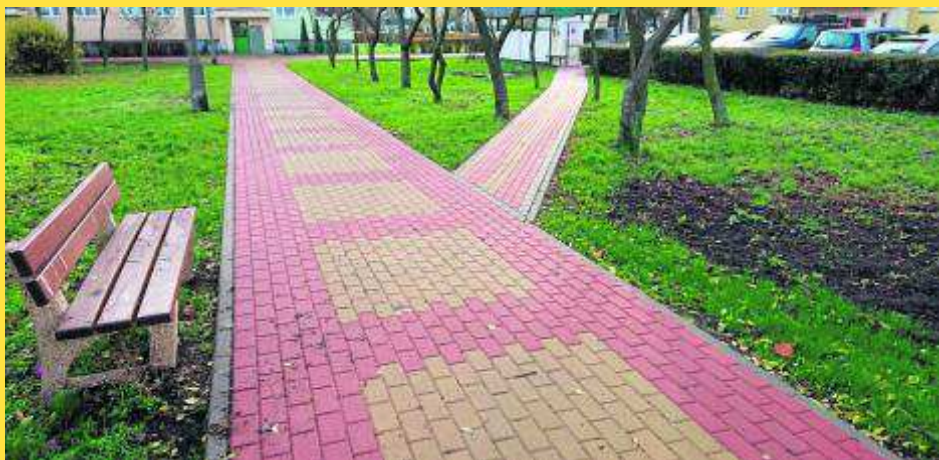
Nowa nawierzchnia chodnika przy ul. Malinowskiego 3
