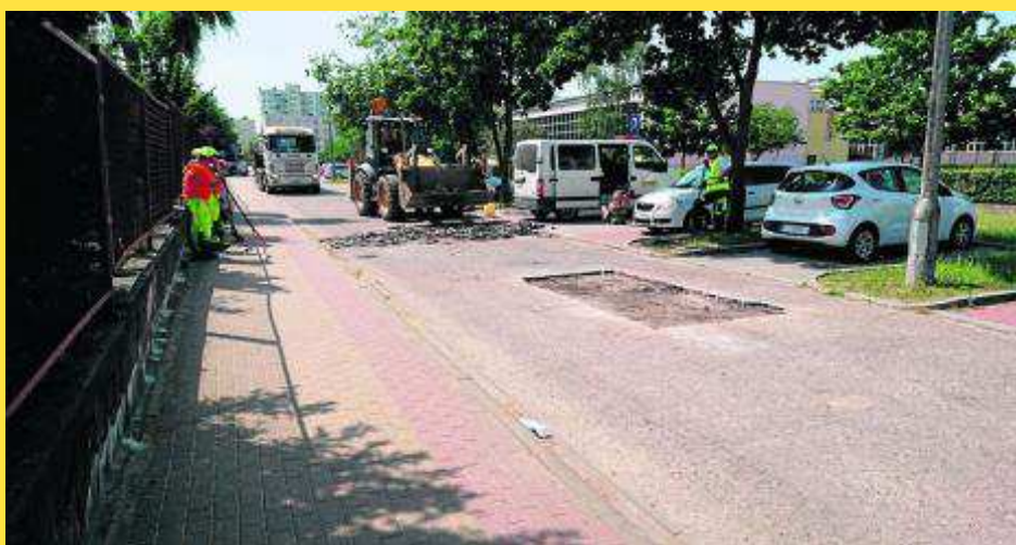
Prace remontowe przy naprawie ulic prowadzone są na całym osiedlu
