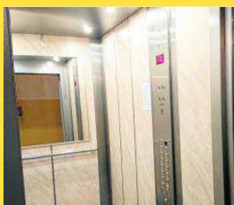
Nowa winda w budynku przy ul. Raszei 4A. W roku 2019 wymienionych zostanie łącznie 12 wind na całym osiedlu
