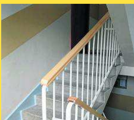
Wyremontowana klatka schodowa przy ul. Witosa 13 jest jedną z 62 klatek, które zostaną odnowione w tym roku
