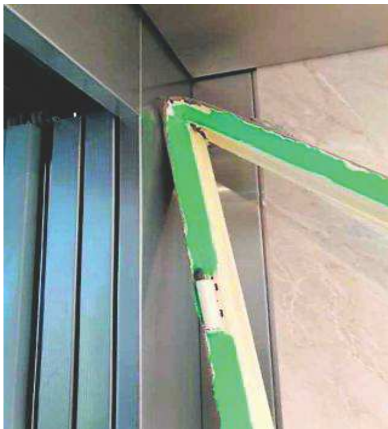
Nieodpowiednie przewożenie materiałów budowlanych...
