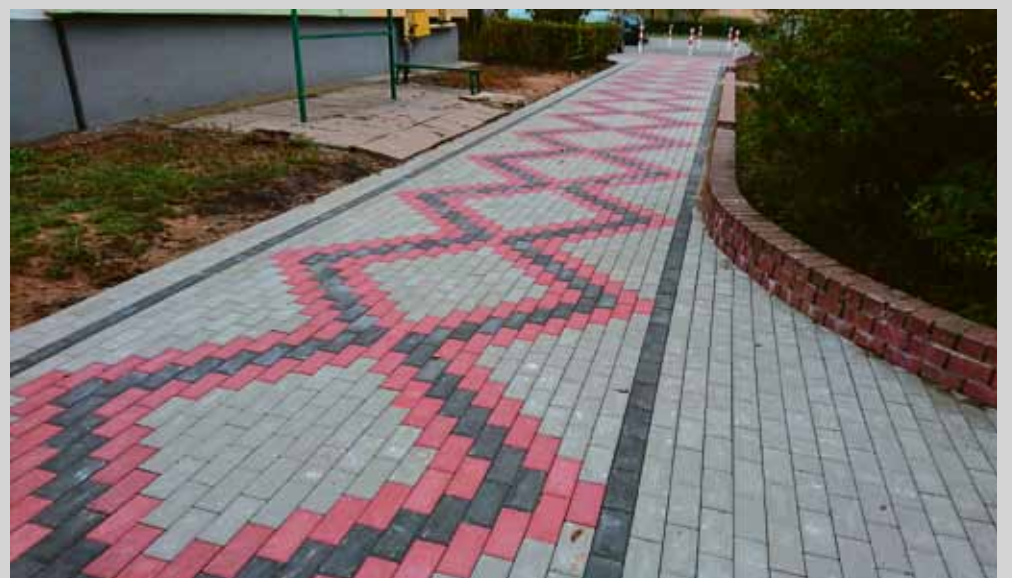
WYREMONTOWANY CHODNIK PRZED BUDYNKIEM PRZY BOLTA 3
