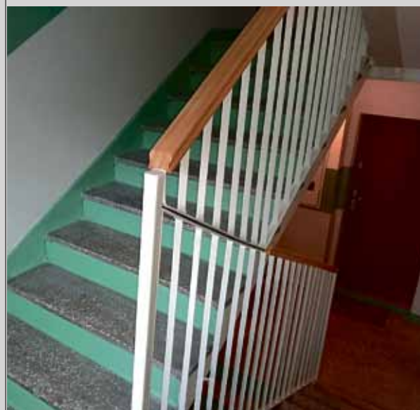
WYREMONTOWANA KLATKA SCHODOWA W BUDYNKU PRZY BOLTA 3. W TYM ROKU ODNOWIONO JUŻ 78 KLATEK SCHODOWYCH NA CAŁYM OSIEDLU
