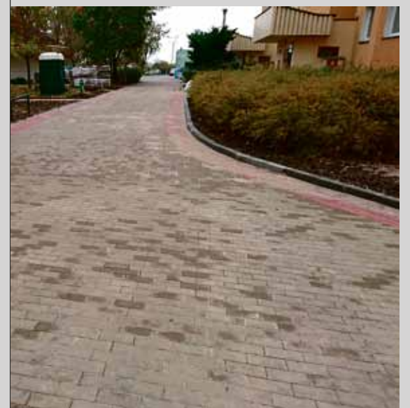
NOWA NAWIERZCHNIA CHODNIKA Pomiędzy BUDYNKAMI PRZY WYSZYŃSKIEGO 11 A RASZEI 2
