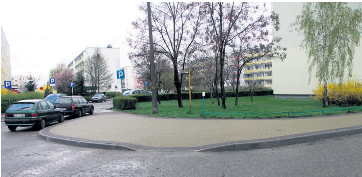
Chodnik przy ulicy Kusocińskiego 12 jest już po remoncie
