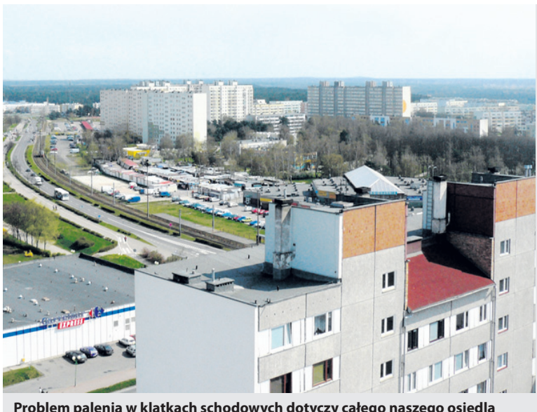
Problem palenia w klatkach schodowych dotyczy całego naszego osiedla
