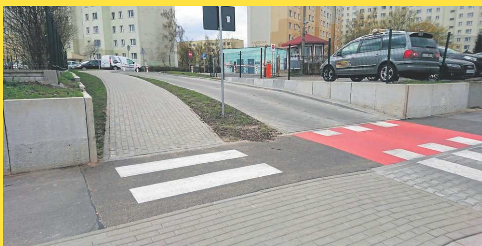
Nowo wybudowany wyjazd z ulicy Raszei
