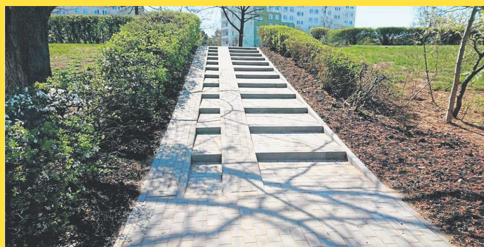
Wyremontowane schody prowadzące do przychodni przy ul. Konstytucji 3 Maja
