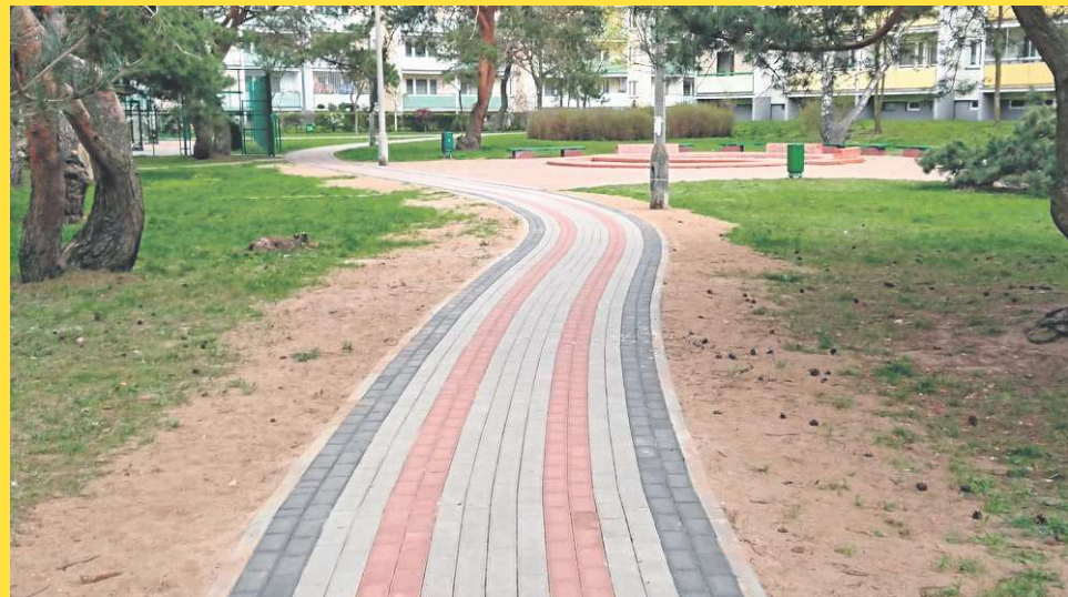
Zmodernizowana nawierzchnia chodnika pomiędzy budynkami przy ul. Tłoczka 1 i 3
