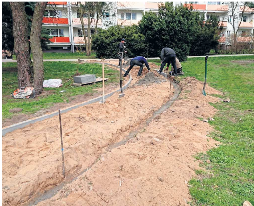
Do remontów chodników i pieszojezdni użytych zostanie prawie 9000m 2 kolorowej kostki betonowej
