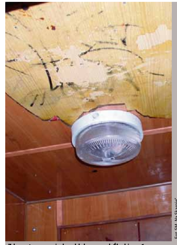
Zdewastowana winda w bloku przy ul. Śląskiego 6
