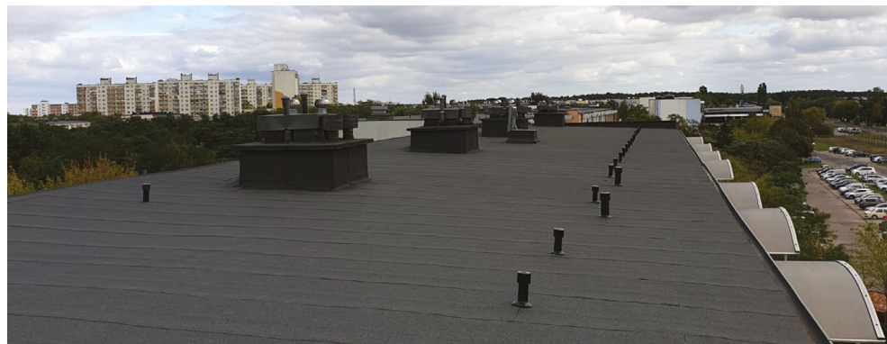
Nowe pokrycie dachu - Przy Skarpie 17
