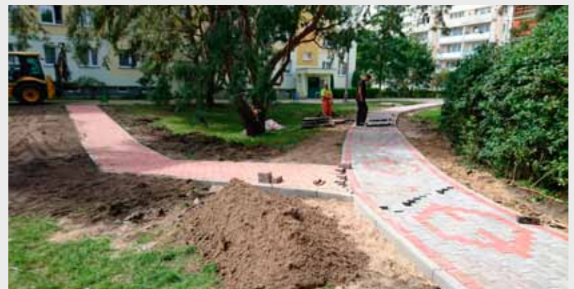
> REMONT CHODNIKA PO POŁUDNIOWEJ STRONIE BUDYNKU PRZY UL. BOLTA 4
