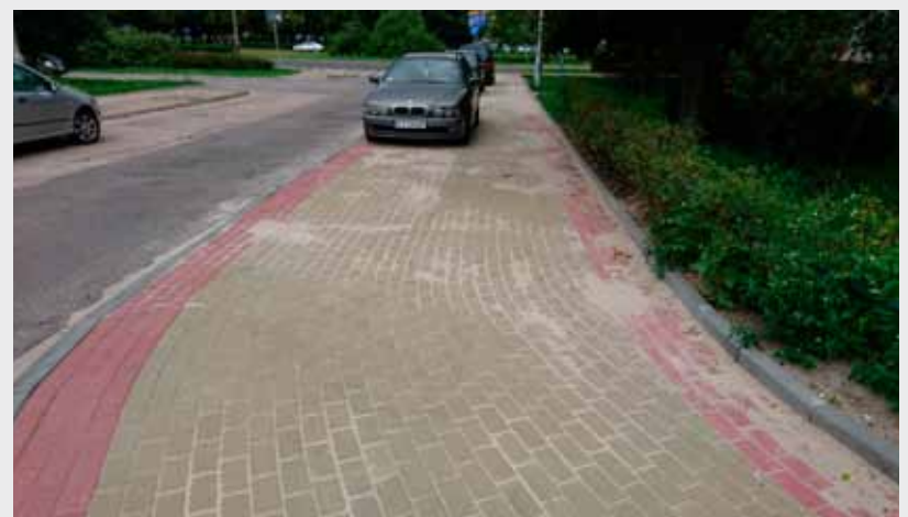
> WYREMONTOWANY CHODNIK PO POŁUDNIOWEJ STRONIE BUDYNKU SZARYCH SZEREGÓW 1
