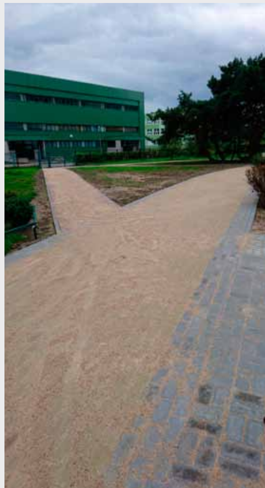
> WYREMONTOWANY CHODNIK POMIĘDZY BUDYNKAMI SREBRNEGO 4 I SULECKIEGO 4 WRAZ Z DOJŚCIAMI DO SZKOŁY
