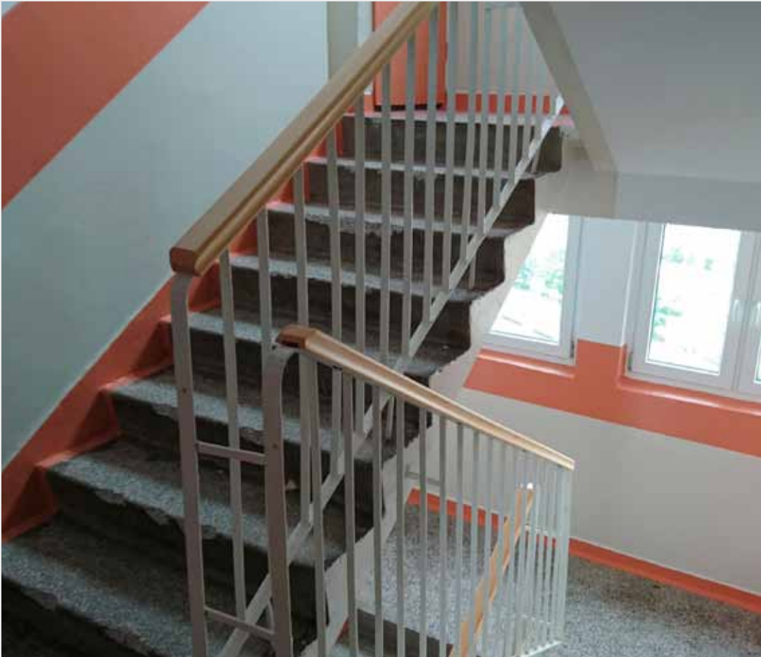
> POMALOWANA 45 KLATKA SCHODOWA NA OSIEDLU W ROKU BIEŻĄCYM W BUDYNKU PRZY UL. KONSTYTUCJI 3 MAJA 20. DO KOŃCA ROKU ZOSTANĄ POMALOWANE ŁĄCZNIE 94 KLATKI SCHODOWE
