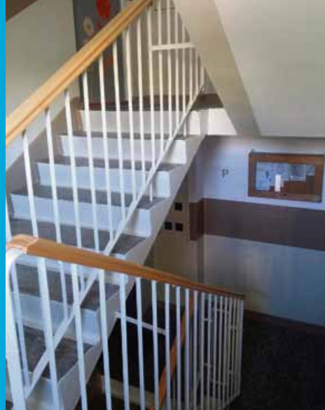
Klatka schodowa w nowej kolorystyce z wymienionymi poręczami – Kusocińskiego 20
