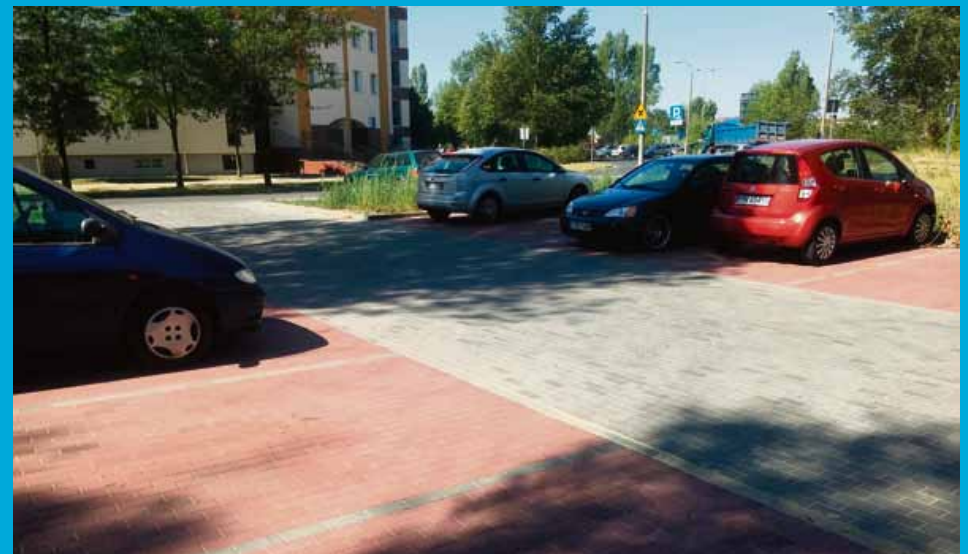
Nowo wybudowany parking przy ulicy Olimpijskiej
