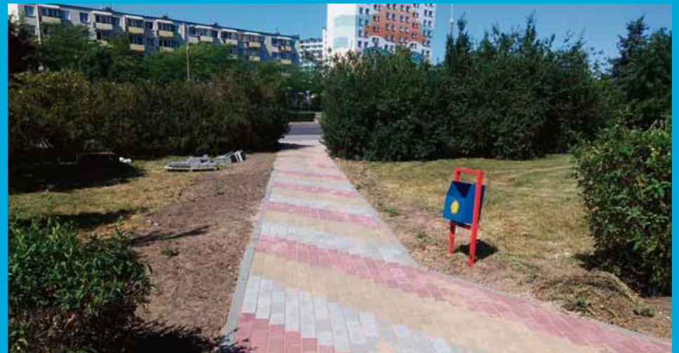
Nowo wybudowany chodnik przy Ligi Polskiej 5
