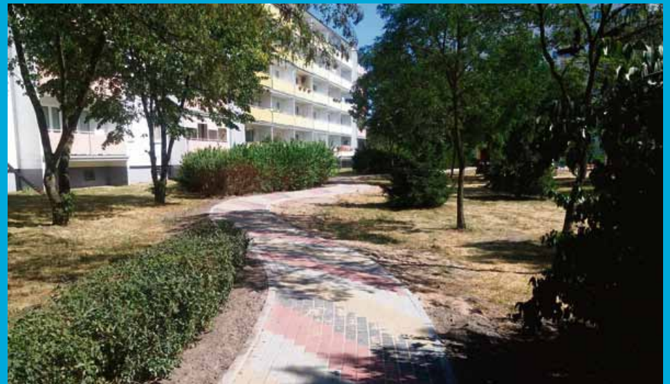
Nowo wybudowany chodnik przy Kusocińskiego 14
