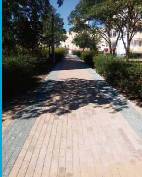
Nowo wybudowany chodnik pomiędzy budynkami Konstytucji 3 maja 23 i 25
