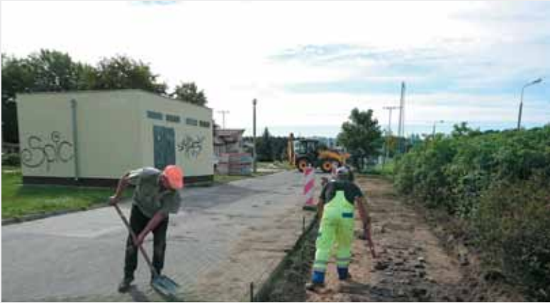
PRACE REMONTOWE NA PARKINGU PRZY BUDYNKU SZARYCH SZEREGÓW 2
